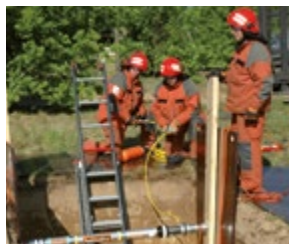
- работа в котловане, траншее
